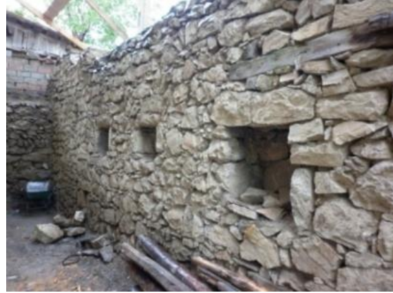
Resim 7. Işıklık detayı (Altunan Özkurt, 2011)
